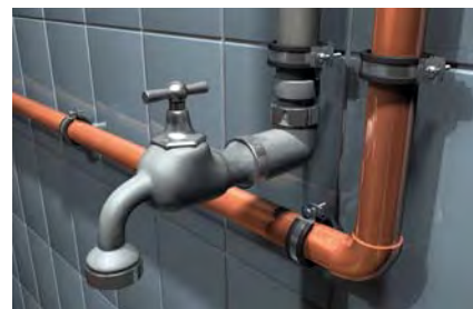
Instalace sanitárního vybavení
