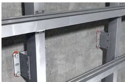
Nosné konstrukce fasád
