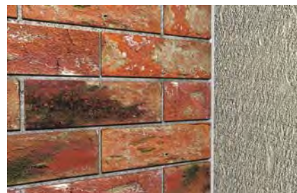
Dilatační spáry mezi budovami
