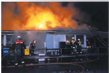
Požár restaurace Aussenalster v Hamburku Budova: Převážně dřevěná, jednopatrová, Postavená na dřevěných pilotech Příčina požáru: Technická závada elektroinstalace, pravděpodobně následkem únavy materiálu Škody na budově: Zničení až na piloty a trémový rošt Výše škody: cca. 0,5 mil. EUR
